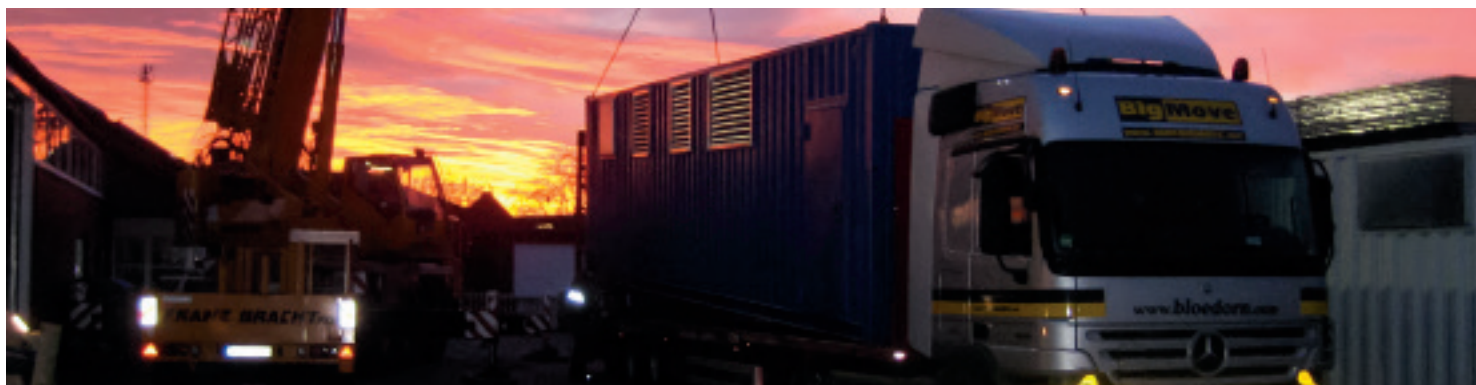
Druckluft-Container-Verladung: Samstag 4.30 Uhr. | 10.45 Uhr Installation am Zielort. | 15.25 Uhr Inbetriebnahme.
