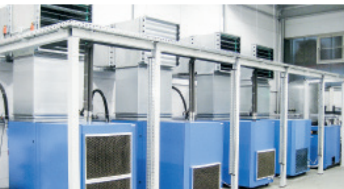
Schlüsselfertige Druckluftlösung mit Schraubenkompressoren.
